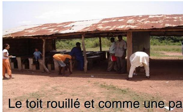
Le toit rouillé et comme une passoire, la charpente pourrit.
