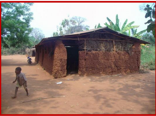
Premier bâtiment en terre battue avec son toit en tôle et son sol cimenté: deux classes.
